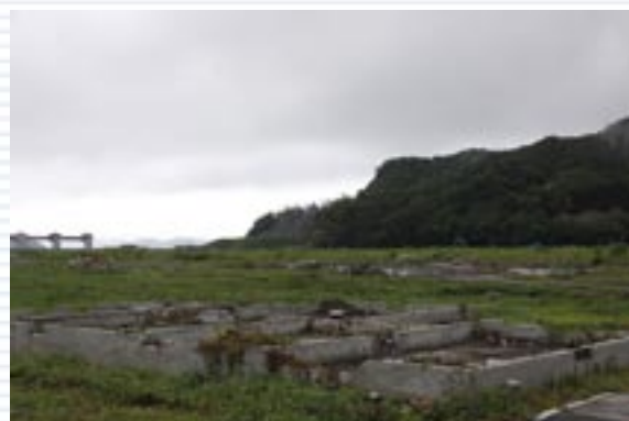
コンクリートの基礎は残っていますが、建物は流されてしまいました。のび放題の雑草ばかりが目につきます。
